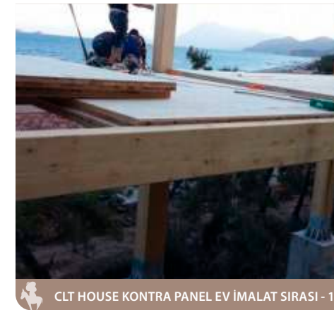
CLT HOUSE KONTRA PANEL EV İMALAT SIRASI - 10
