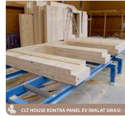
CLT HOUSE KONTRA PANEL EV İMALAT SIRASI - 1
