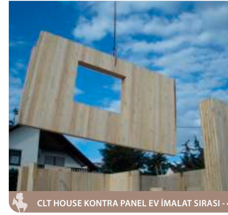
CLT HOUSE KONTRA PANEL EV İMALAT SIRASI - 5
