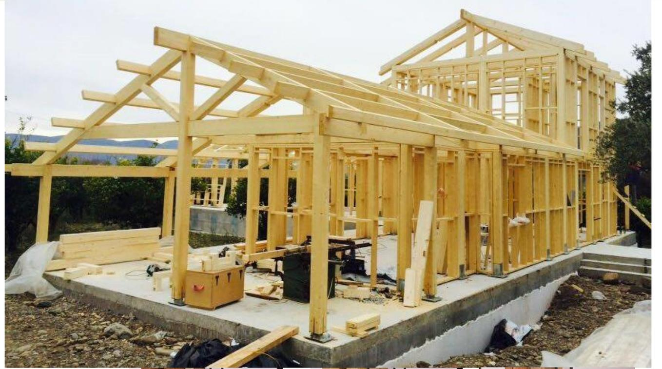
Ahşap duvarlar ,ahşap pencereler, kapılar, merdivenler diğer tüm ahşap kısımlar önceden fabrikada projeye göre hazırlandığından montaj çok hızlı gerçekleşmektedir. Fakat beton evlerde şantiyede toplanan malzemeler daha uzun sürelerde daha kontrolsüz şekilde montajlanır.
