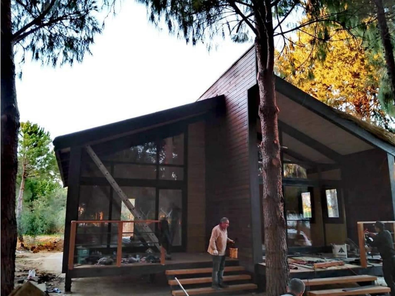
Fabrikamızda üretip , sahada montajını sağladığımız toplam brüt 105 m<sup>2</sup> olan bu evimiz 14 gün gibi kısa bir sürede teslim edilmiştir.
